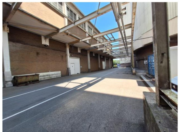
Aanzicht van bestaande deur en de bestaande overkapping
