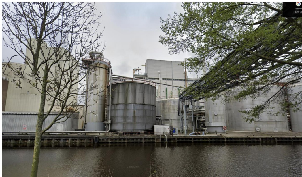
f 5.1 Huidige situatie CBCV-terrein vanaf het Hoendiep ter plaatse van de projectlocatie
