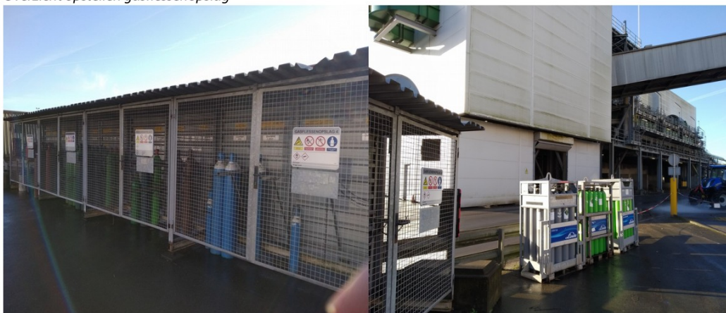
f3.7 Overzicht opstellen gasflessenopslag
