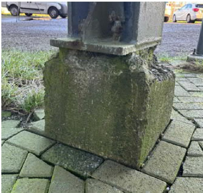
Foto 1: Schade opstorting/ankers
