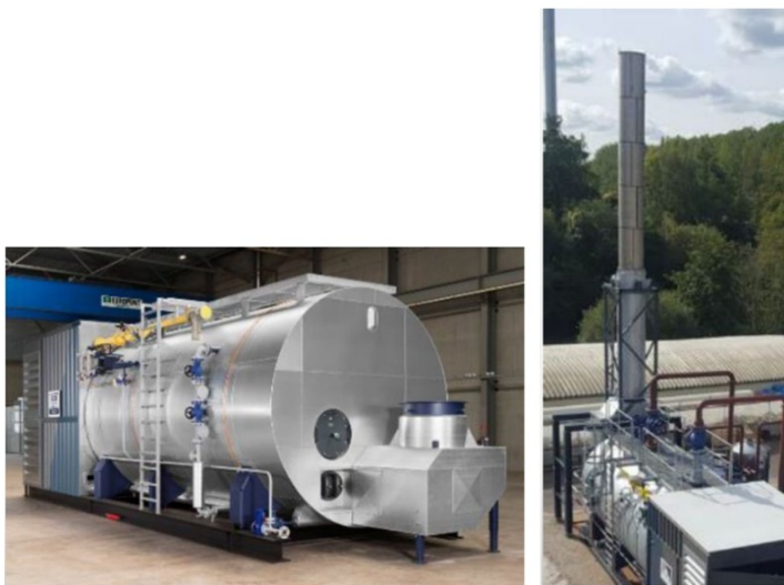
Figuur 4 : foto Eco Ketel (links) met schoorsteen (rechts)
