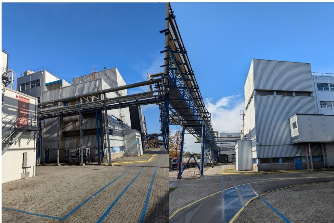
Figuur 5.2 Bestaande verpakingsruimte (gebouw 214)
