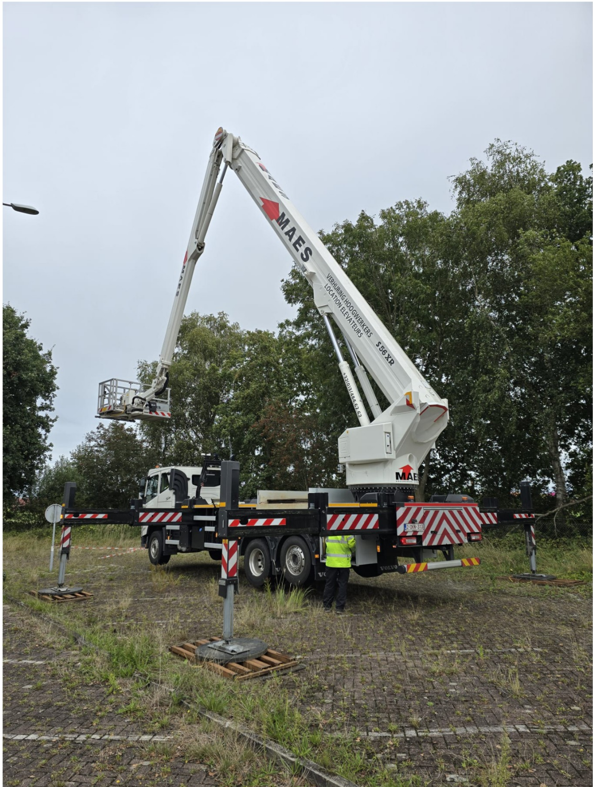
Afbeelding 2 Positie hoogwerker nabij mast locatie.
