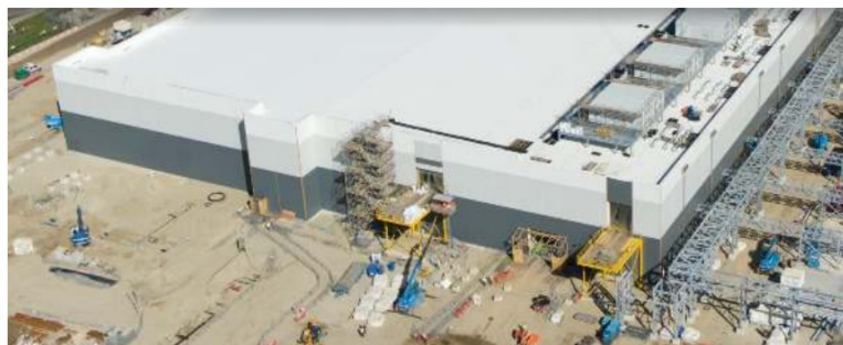
Afbeelding 2. Gebouwd datacenter naast pad 4.
