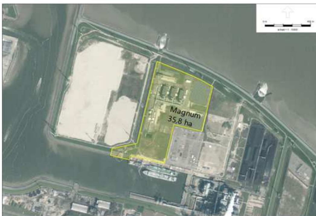
f.2.1 Terrein Magnumcentrale
