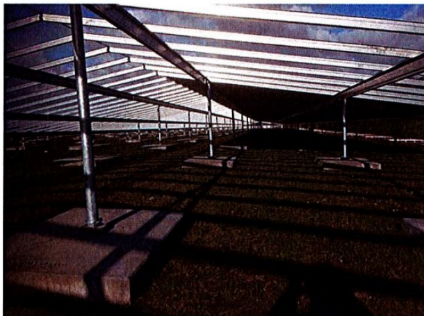
Afbeelding 4: Foto constructiepoten (ter indicatie, poten Woldjerspoor zijn hoger)
