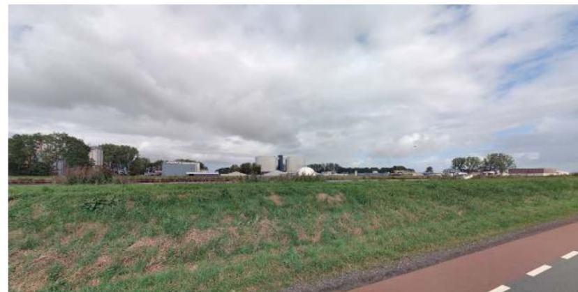
Foto vanaf Eemskanaal Zuidzijde richting de RWZI, vanaf 2,4m hoogte. Bron: Cyclomedia
