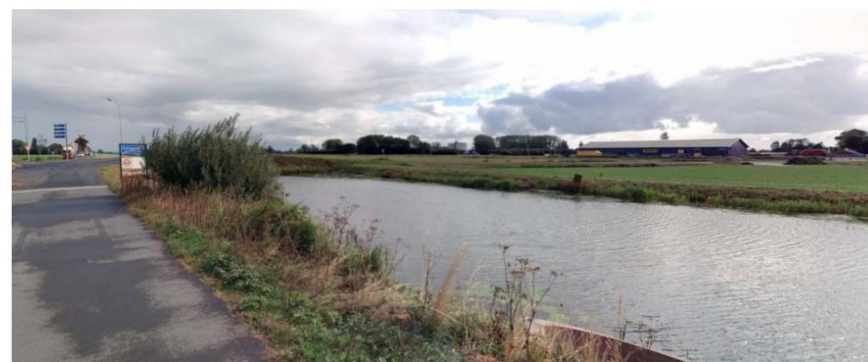
Foto van de huidige situatie vanaf de rand van Garmerwolde in de richting van de RWZI
