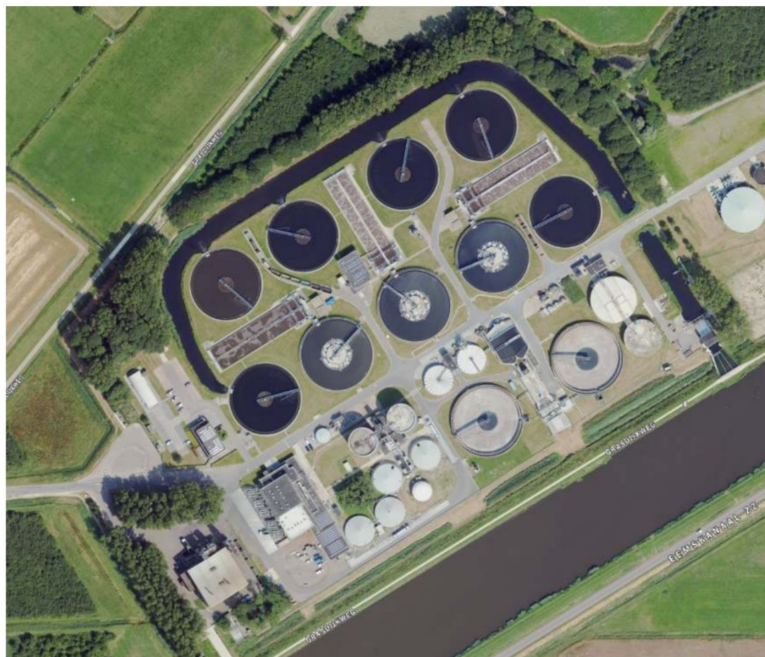
Luchtfoto van het terrein van de RWZI uit 2022
