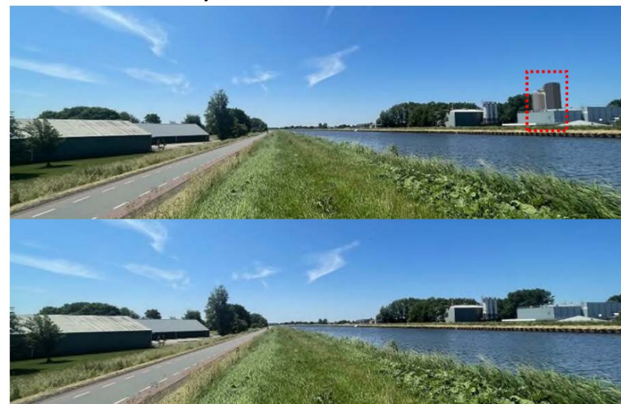
Foto-inpassing (boven) en huidige situatie (onder) van de nieuwe Slibkoekoverslag
