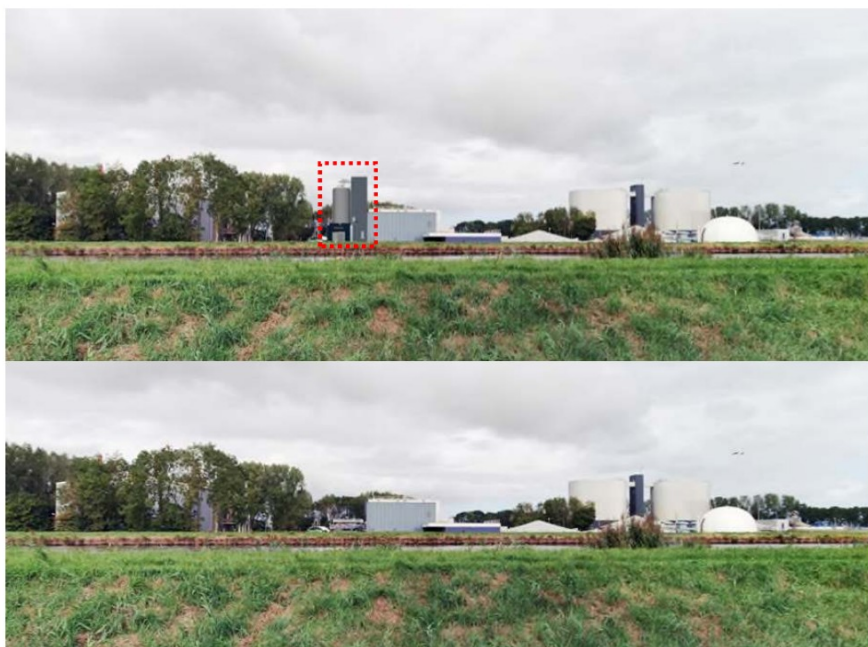
Foto-inpassing (boven) en huidige situatie (onder) van de nieuwe Slibkoekoverslag
