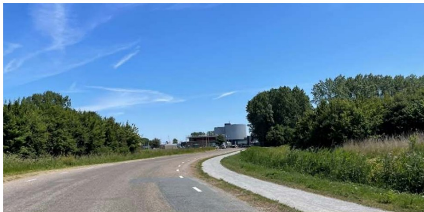
Foto van de huidige situatie vanaf de toegangsweg richting de RWZI
