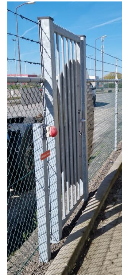
Impressie Nooduitgang hekwerk + Knop Afsluiter Riool
