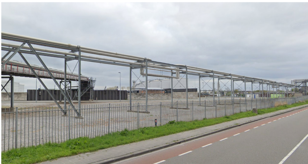
f2.2 Impressie huidige situatie beoogde locatie opslagtanks
