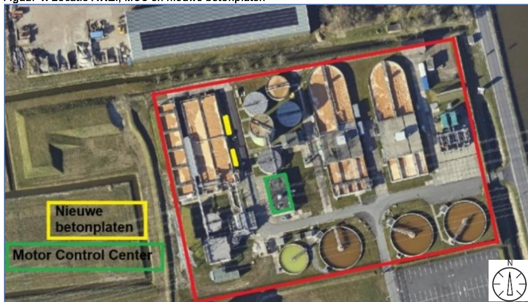
Figuur 1: Locatie AWZI, MCC en nieuwe betonplaten
