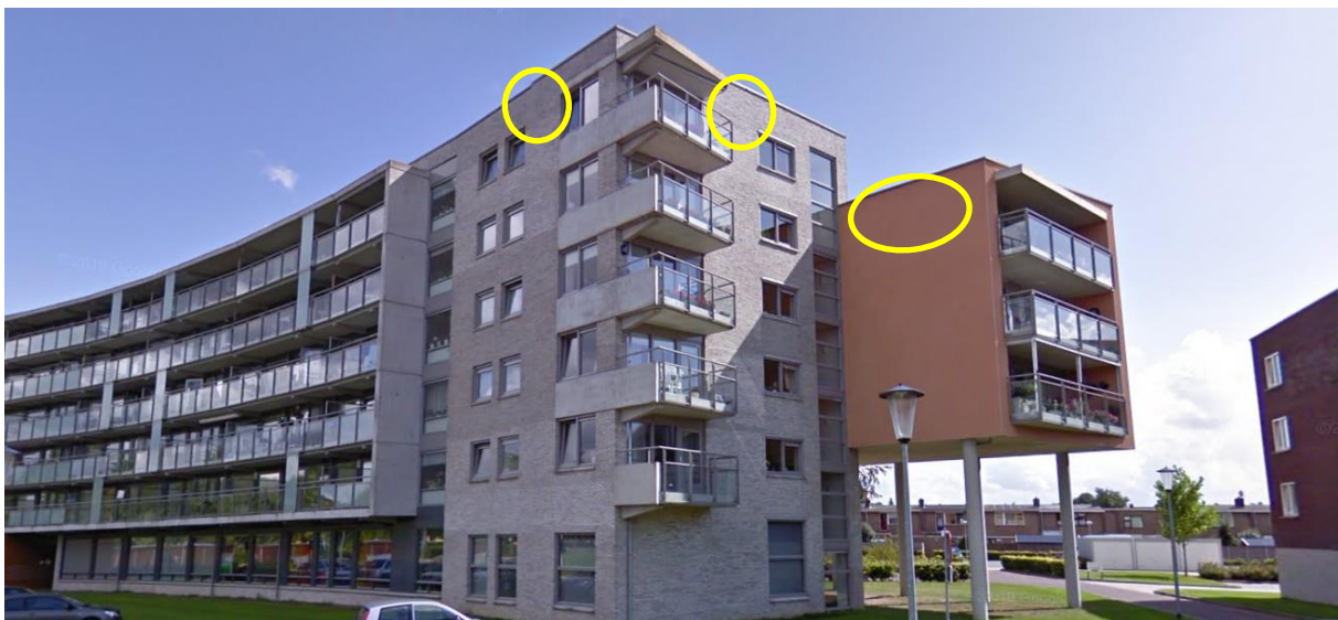
Figuur 5.7 Voorbeeld locaties vleermuiskasten (geel omcirkeld) zuid deel Meridiaan flat (Schaepmanstraat 21) (bron: Google Street View).
