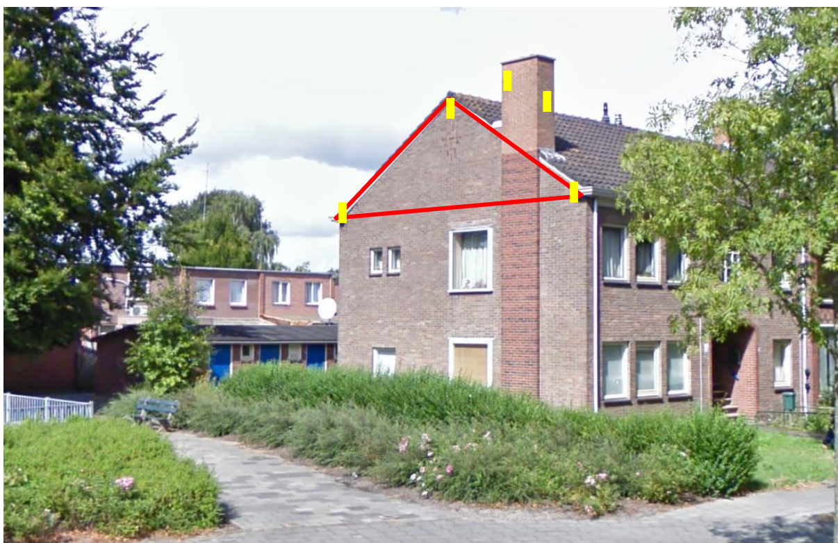
Figuur 5.3 Weergave van ruimte die niet gevuld wordt met isolatiemateriaal (rood) en globale locatie extra open stootvoegen (geel) kopgevel en schoorsteen Vredenrustlaan 70/70A (bron: Google Street View, 2021).
