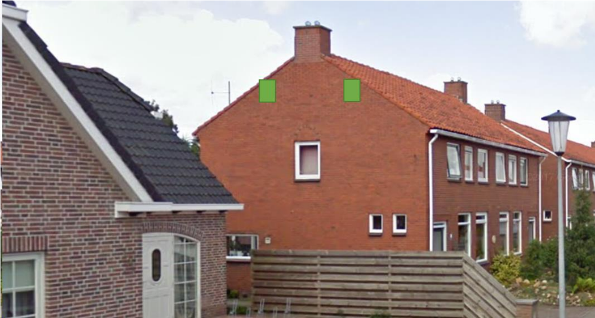
Figuur 5.6 Voorbeeld locatie vleermuiskasten (groen) kopgevel Frans Spiekmanstraat 1 (bron: Google Street View).
