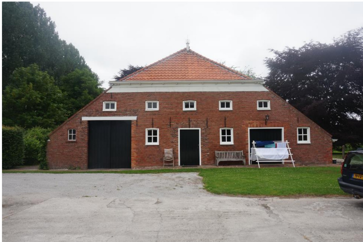
Achtergevel van de schuur
