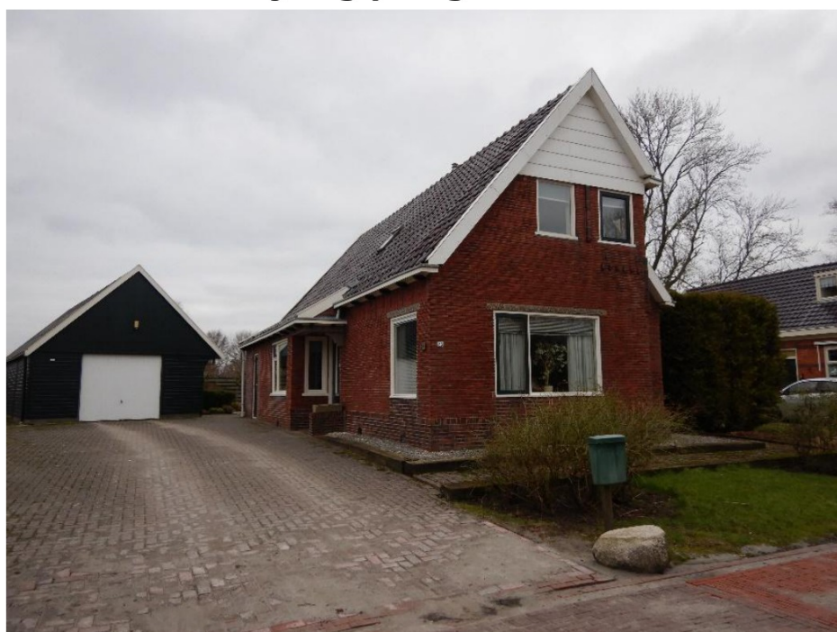
Figuur 1: De voorgevel van de woning aan Borgweg 83 in Zeerijp.
