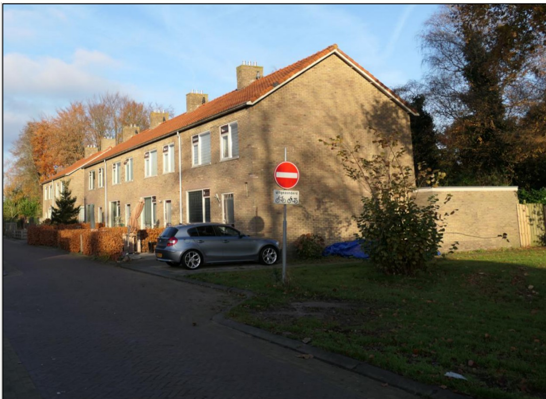
Figuur 2.3 Woningen aan de Schaperstraat (nummer 23 tot en met 28) behorende tot complex 1252a.
