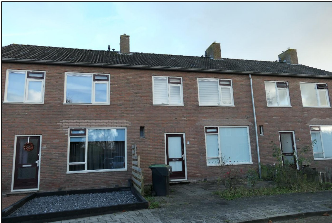
Figuur 2.2 Woningen aan de Schaperstraat (nummer 45 tot en met 49) behorend tot complex 1252a.
