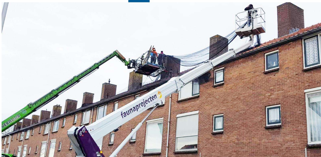
Afbeelding 3.2 Het aanbrengen van daknetten door Unitura (voorheen Faunaprojecten)
