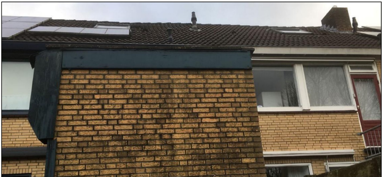
Figuur 5.5. Voorbeeld van een boeideel gerealiseerd als vleermuisverblijfplaats (bron: Vleermuiswerkgroep Nederland, 2024).
