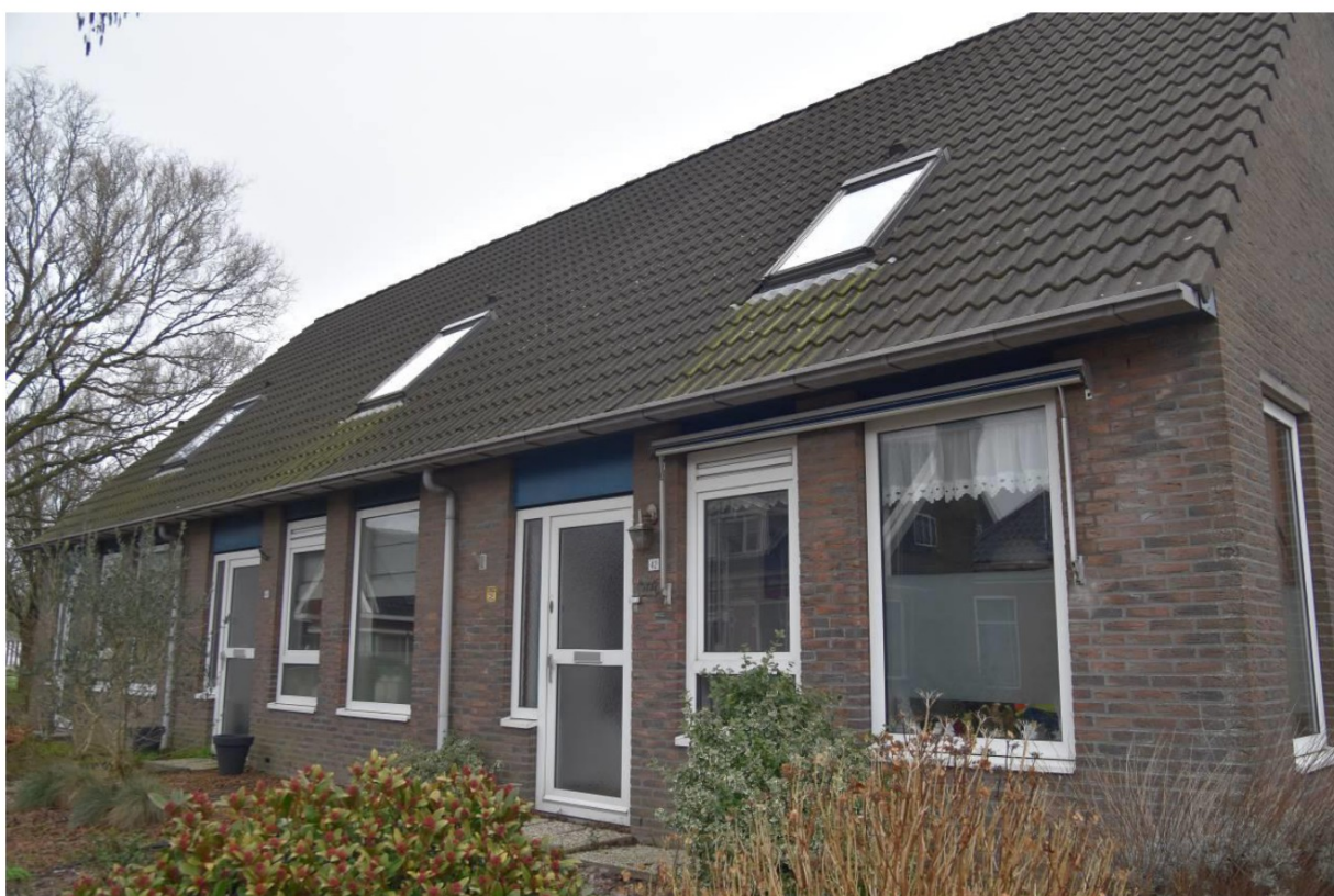
Figuur 2.4 Indruk van de woningen aan de Departementsstraat 42 tot en met 48.
