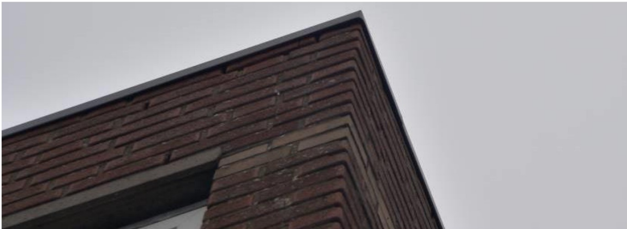
Figuur 4.2 De dakranden langs de platte daken van de woningen binnen het projectgebied sluiten te strak aan voor gierzwaluwen en huismussen, maar geven vleermuizen mogelijk toegang tot het dakvlak en/of de spouw.
