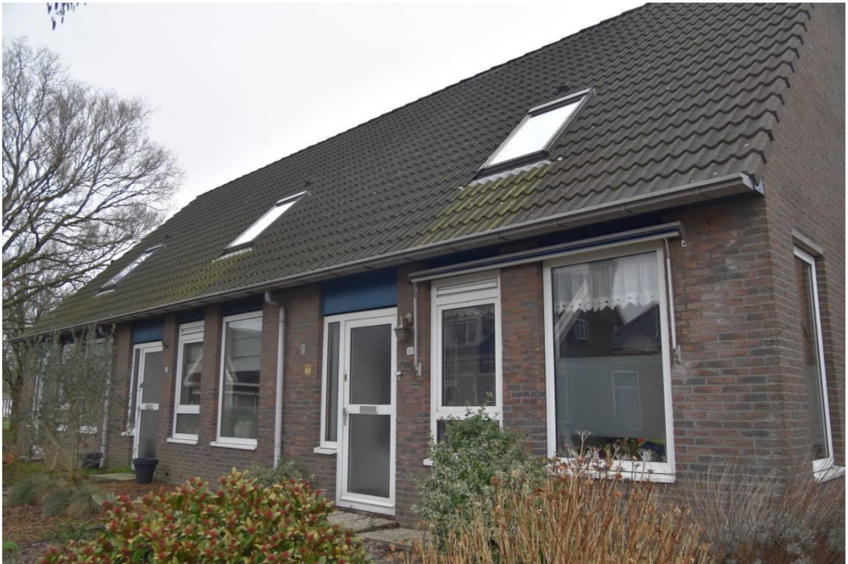
Figuur 1.3 Indruk van de woningen aan de Departementsstraat 42 tot en met 48.
