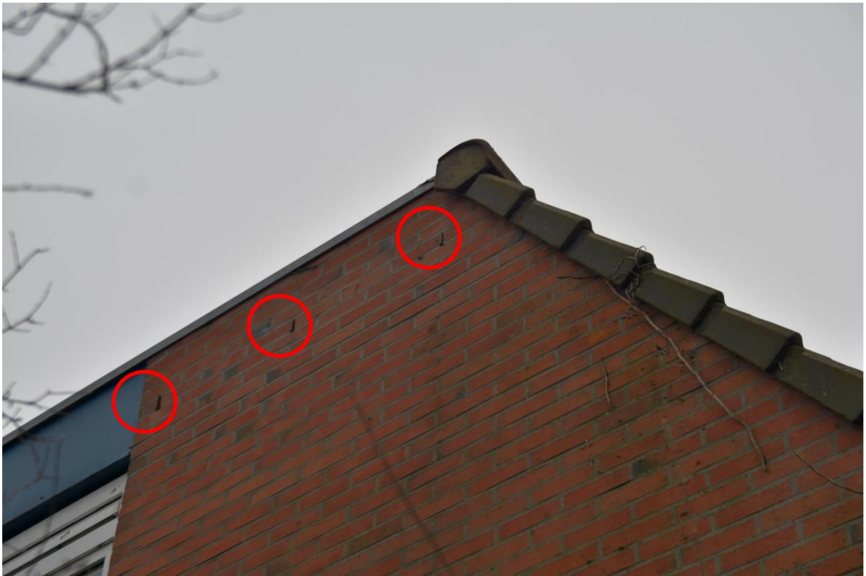
Figuur 4.6 Stootvoegen in de gevels van een deel van de woningen binnen het projectgebied geven vleermuizen toegang tot de spouw.
