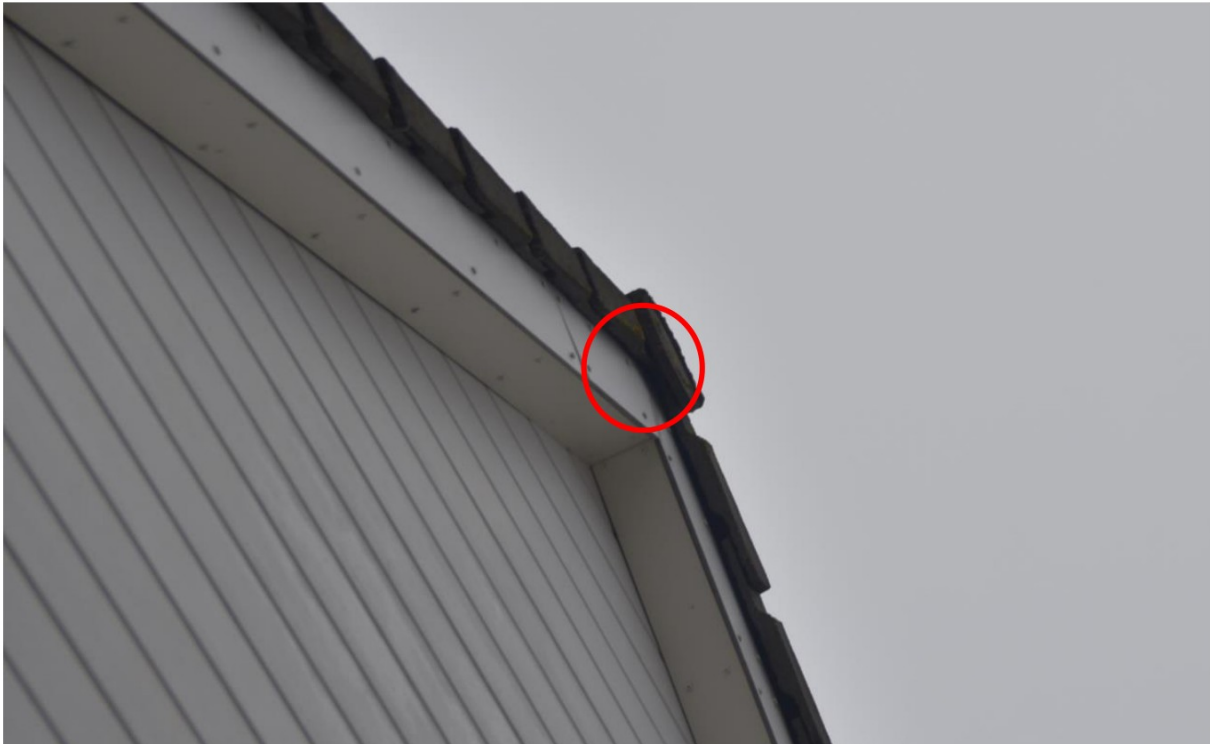
Figuur 4.4 De eindvorsten van een deel van de woningen binnen het projectgebied bieden toegang tot het dakvlak en mogelijk tot de spouw aan gierzwaluw en vleermuizen.
