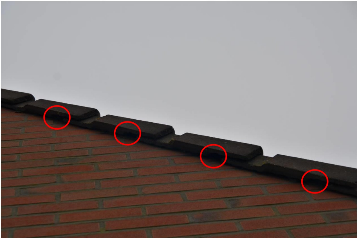
Figuur 4.3 De kantpannen van een deel van de woningen binnen het projectgebied bieden toegang tot het dakvlak en mogelijk tot de spouw aan gierzwaluw en vleermuizen.
