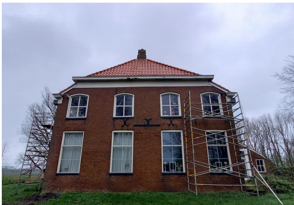
Afbeelding 1.1 Vooraanzicht bebouwing aan de Pastorieweg 8 te Nieuw Scheemda.
