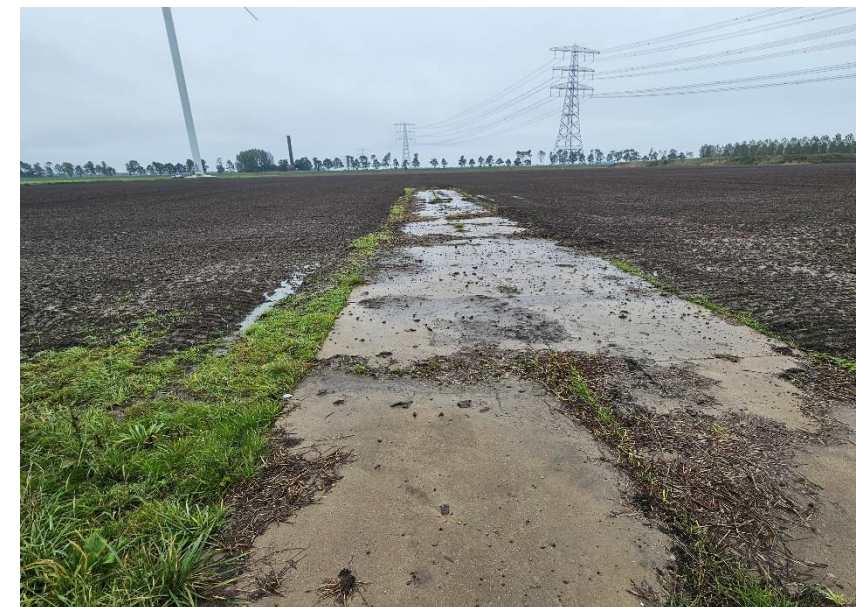
Figuur 12: Verharde landbouwweg binnen plangebied
