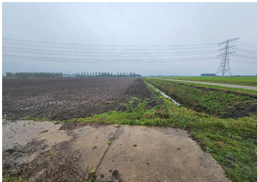
Figuur 10: Verharde landbouwweg binnen plangebied, vanuit westen
